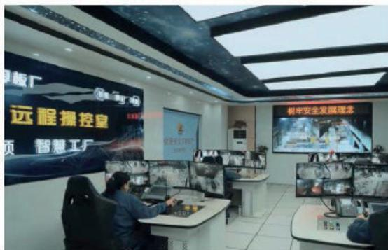
Компания Huawei вместе с оператором связи China Mobile Hunan помогают металлургическому заводу Valin Xiangtan Iron & Steel в провинции Хунань использовать сеть 5G для дистанционного управления кранами
